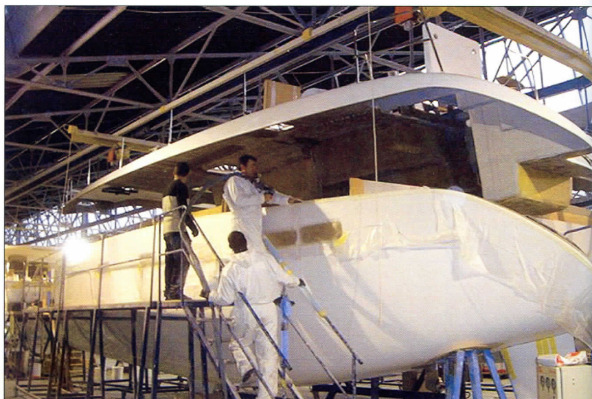
Assemblage pont-coque sur catamaran avec une colle méthacrylate.
