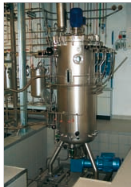
Fabriqué et installé en Allemagne par la société 3C, ce fermenteur a une contenance de 600 L.
