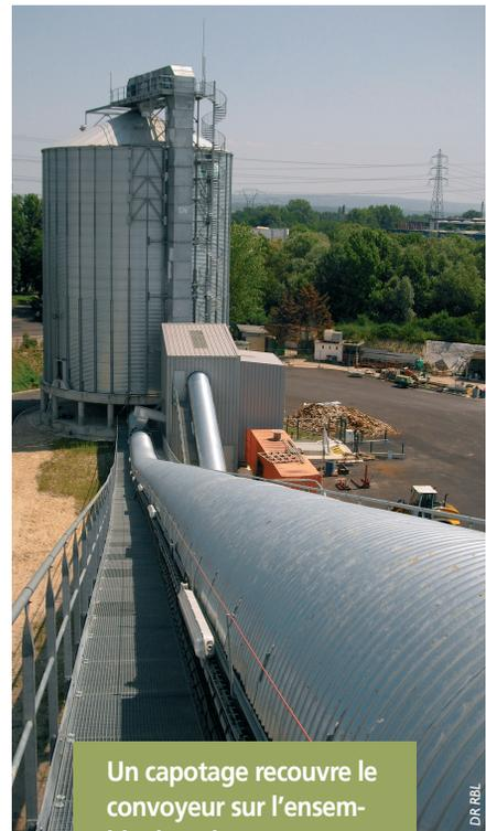
Un capotage recouvre le convoyeur sur l'ensemble de sa longueur.
