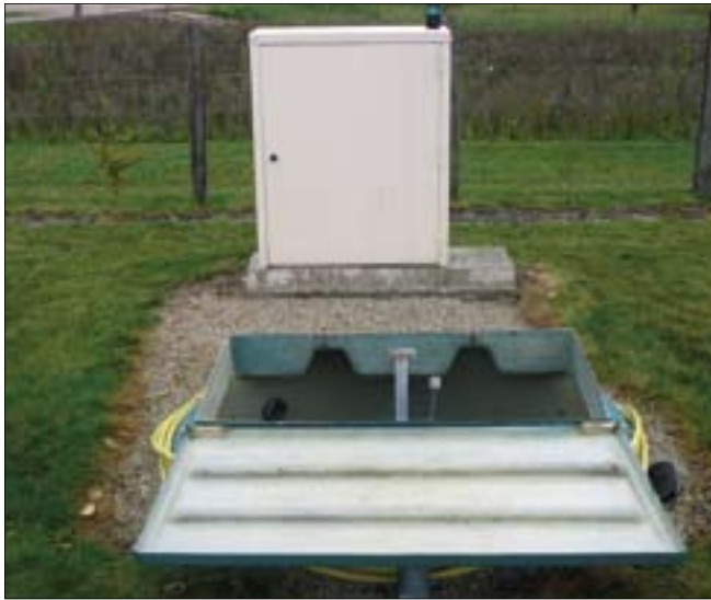
Poste de refoulement Salmson « SIR Delta », équipé de trois pompes submersibles « FA ». Il reprend la totalité des effluents et les distribue alternativement sur les lits de roseaux.
