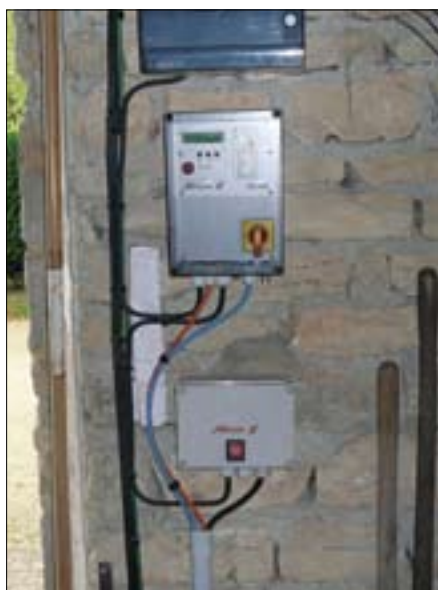
Coffret de commande « YN 3000 » installé chez chaque particulier.
