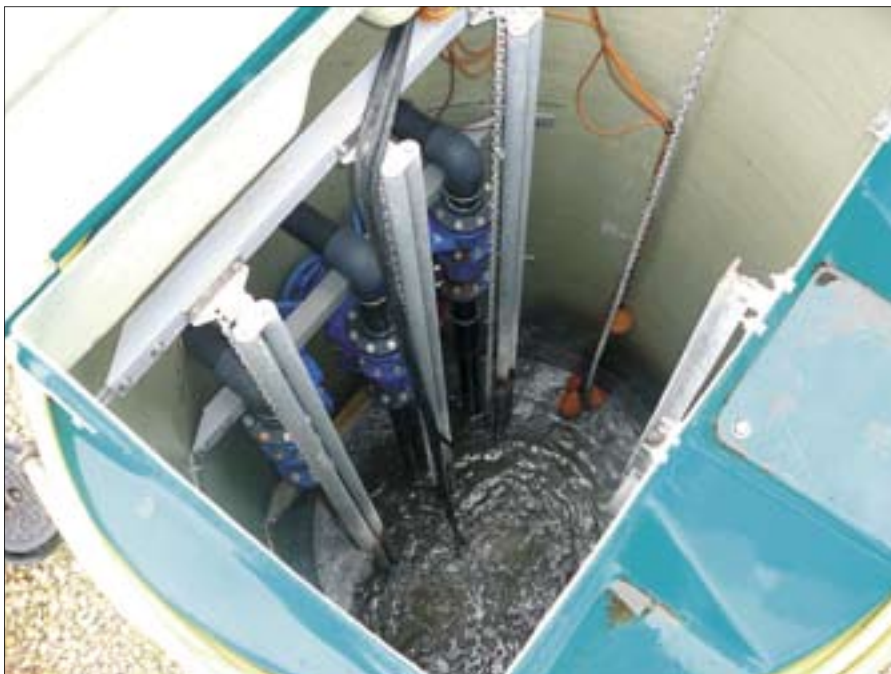
Poste de refoulement Salmson « SIR Delta », équipé de trois pompes submersibles « FA ». Il reprend la totalité des effluents et les distribue alternativement sur les lits de roseaux.
